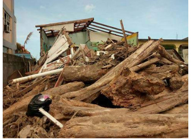
Inte bara vinden gjorde skada utan även de stora vattenmassorna som drog med sig allt i sin väg.
